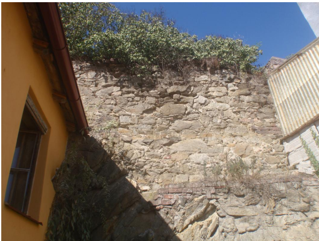
Pohled na řešenou část opěrné stěny. Zeď je narušena jednak liniovým rozpadem koruny a dlouhodobým vyplatováním a degradací pojiva.
